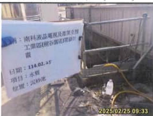
工區放流水水質檢測~沉砂池(114/02)
