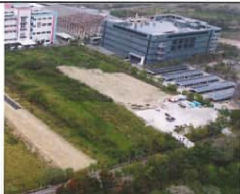
紫棟路停車場男廁本季有整地工程正在進行
