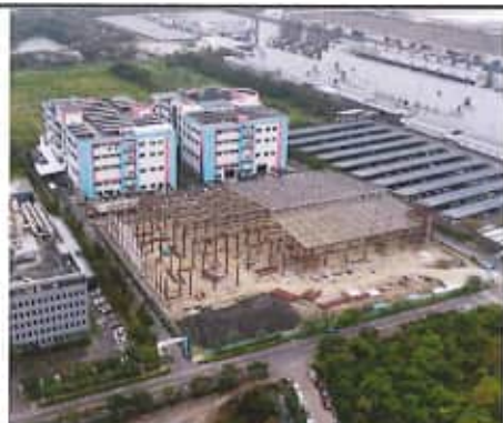
家登精密舊廠房北側有新廠房正在新建
