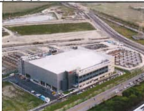
南側南科三期(原看西農場)興建工程持續進行中，帆宣科技公司六廠已近完工
