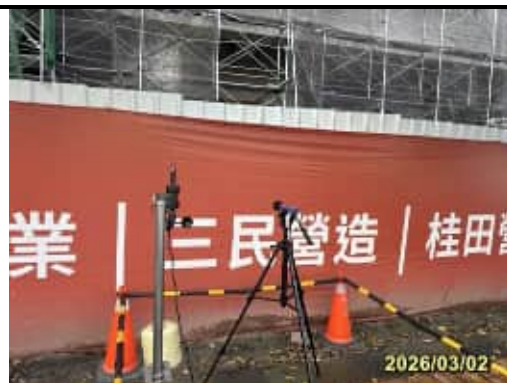
營建噪音檢測~工區周界外(115/03)
