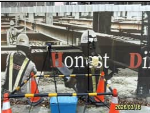
營建噪音檢測~工區周界外(115/03)
