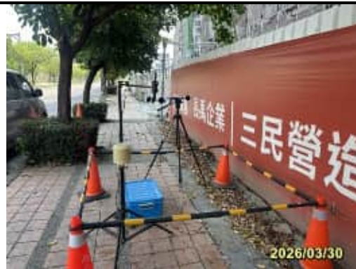
營建噪音檢測~工區周界外(115/03)
