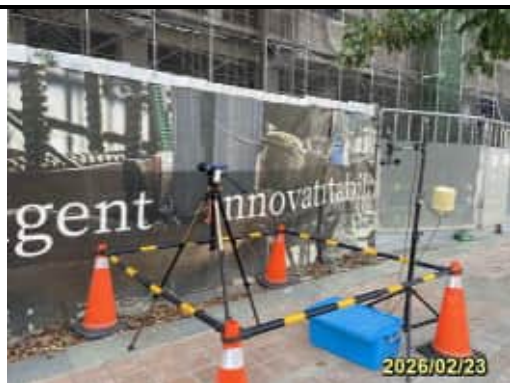
營建噪音檢測~工區周界外(115/02)
