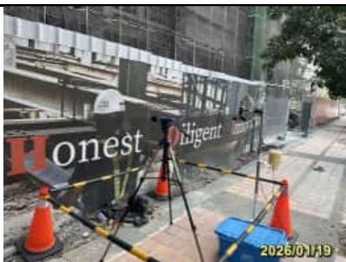
營建噪音檢測~工區周界外(115/01)
